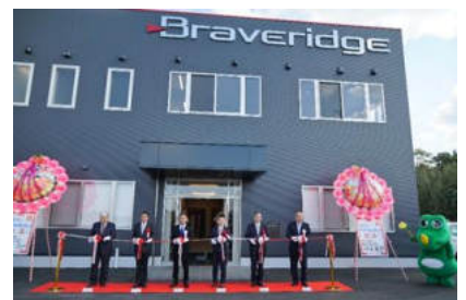
糸島新工場の竣工式
